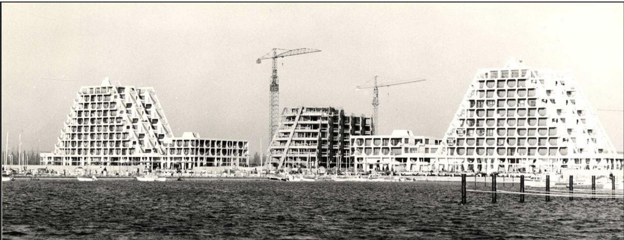
Construction de la Tour Fenestrel à la Grande Motte ©Bob Ter Schophors/ OT La Grande Motte
