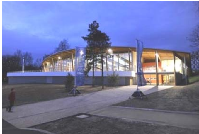
Centre nautique de Bayonne
